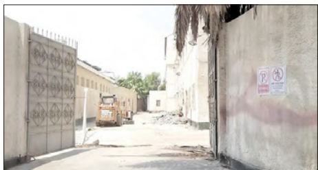
بدء أعمال الصيانة بمدرسة فاطمة الزهراء الابتدائية للبنات
